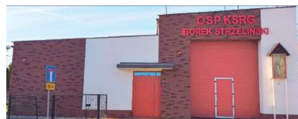
Remiza w Borku Strzeleckim przeszła termomodernizację. Fot. UG w Borowie
