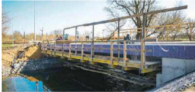
Remontowany most na ulicy Augustiańskiej
