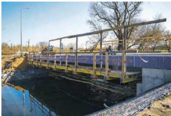
Most na Łydni (w ul. Augustańskiej) w budowie
