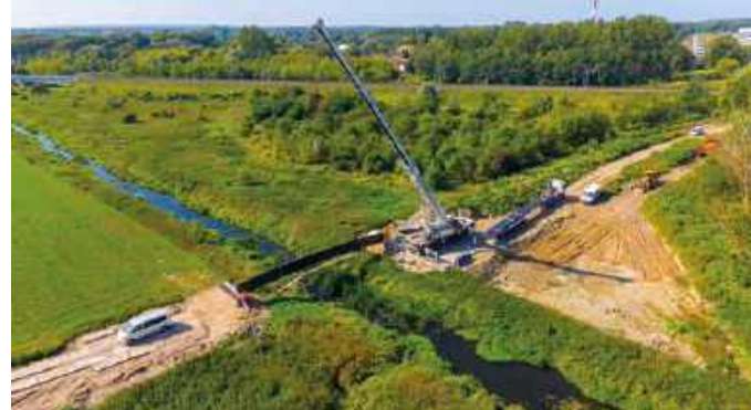
Budowa przeprawy przez Łydnię
