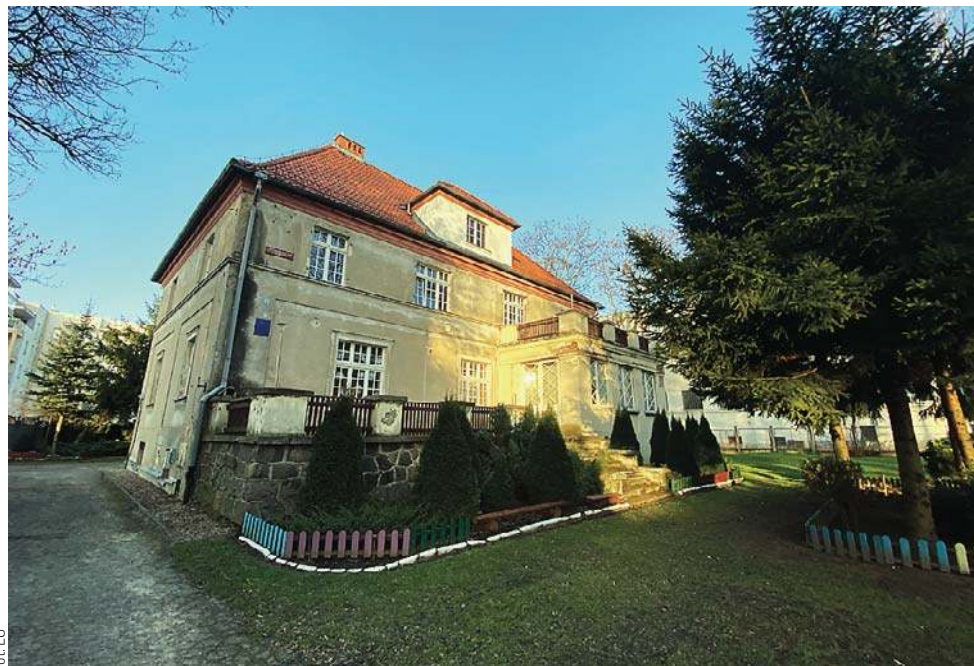
Na liście wyczekiwanych przez mieszkańców Elbląga inwestycji jest m.in. remont zabytkowego budynku, w którym mieści się Przedszkole nr 8
