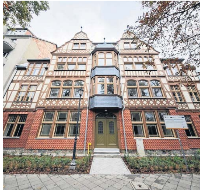
Tak wygląda kamienica przy Bydgoskiej 50-52 po remoncie
