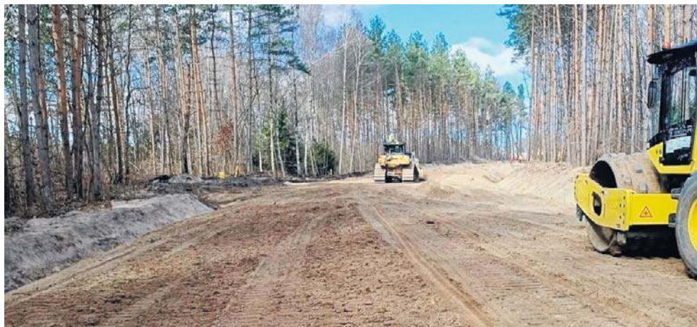
Budowa drogi łączącej Redzikowo z Jezierzycami weszła w decydującą fazę. Koszt inwestycji to ponad 90 mln zł
