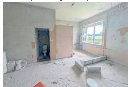
Remontowane pomieszczenia sanitarne
