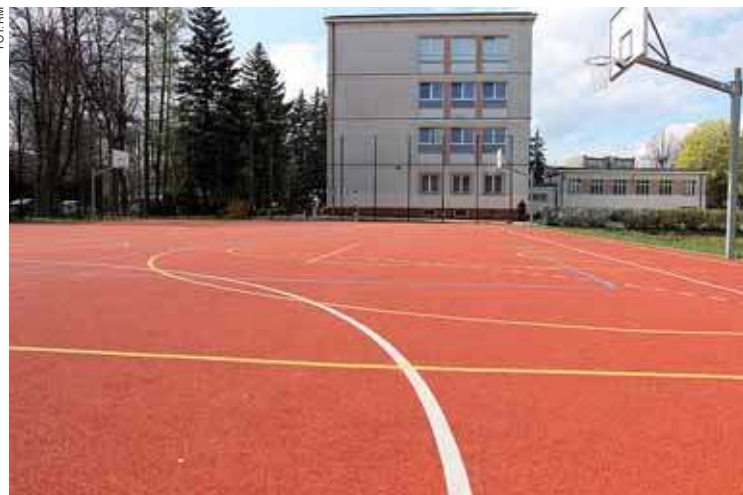
Wyremontowane boisko przy ZS nr 1 w Ciechanowie
