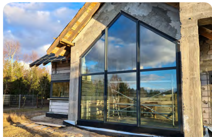
Umieszczenie okien po stronie południowej zapewni większy komfort termiczny zimą. Latem natomiast można je zasłonić na przykład roletami zewnętrznymi, by mieszkanie nadmiernie się nie nagrzewało.
