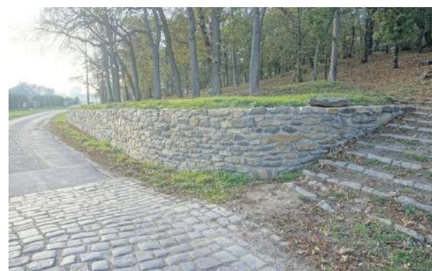
Odtworzenie muru oporowego kosztowało łącznie 35 000 zł (Foto. UMiG Strzelin)
