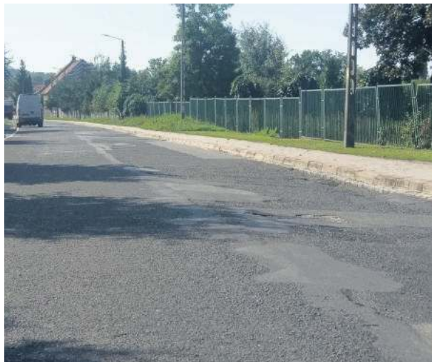
Na ulicy Marii Konopnickiej zaplanowano remont nawierzchni jezdni
