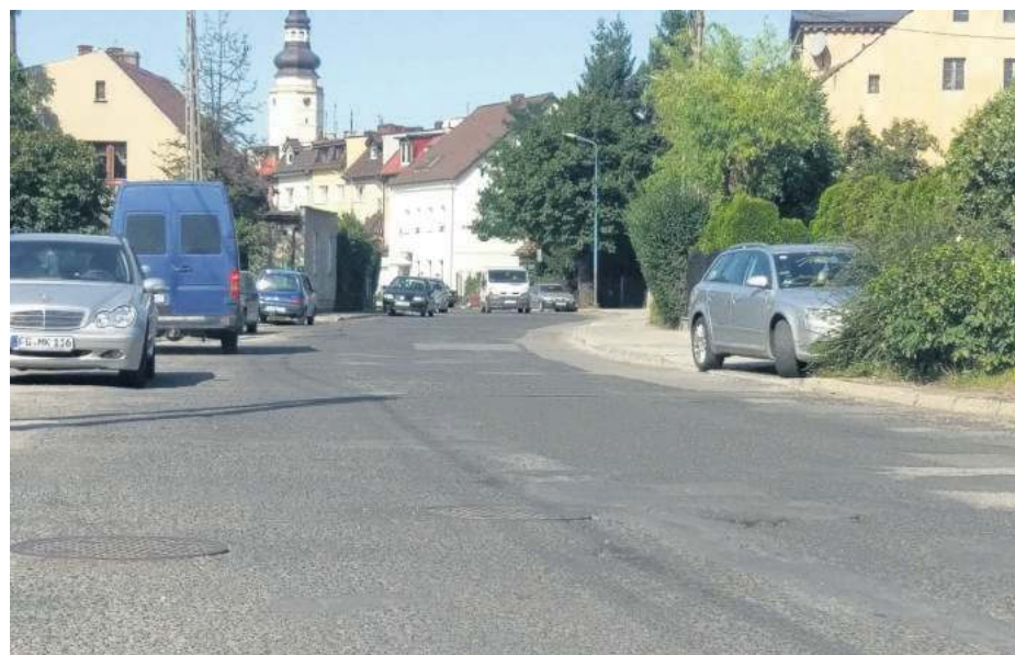
Zakres prac na ulicy Brzegowej obejmuje zarówno nową nawierzchnię bitumiczną jezdni i remont chodnika
