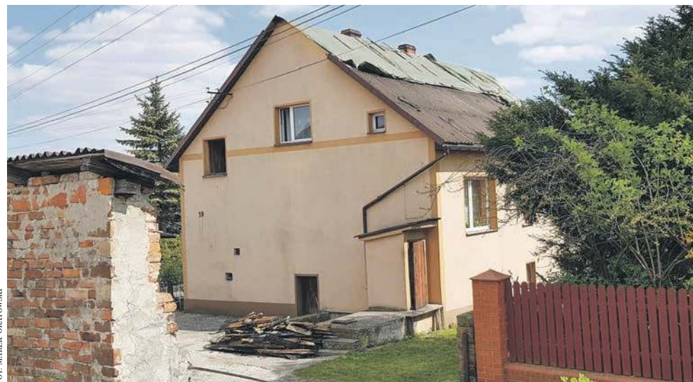
Tak wyglądał budynek przy ulicy Ciasnej w Balinie dzień po pożarze
