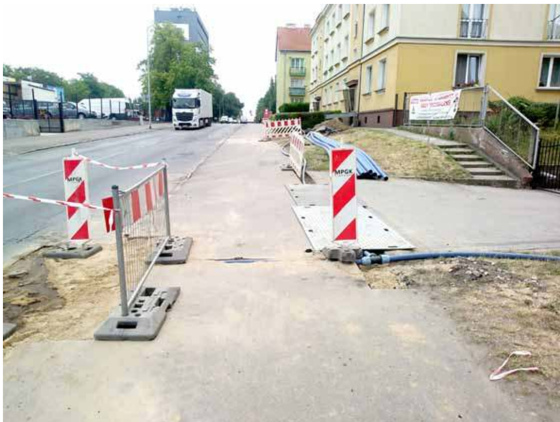
Na odcinku około 320 metrów MPGK prowadzi prace związane z remontem sieci wodociągowej
