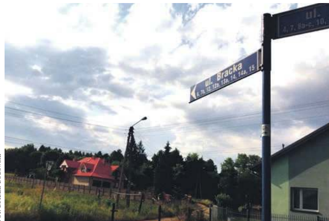
Mieszkańcy Brackiej od wielu lat proszą o modernizację sieci wodociągowej
