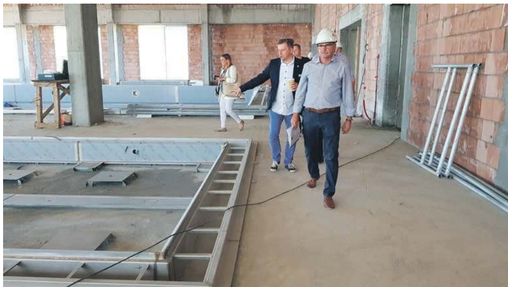
Burmistrz Jacek Latko na budowie basenu. Na tę inwestycję gmina w ubiegłym roku wydała 11 milionów złotych
