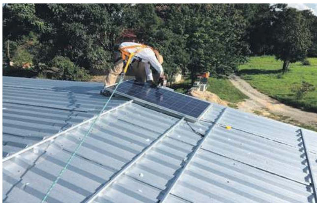
Montaż paneli na dachu domu
