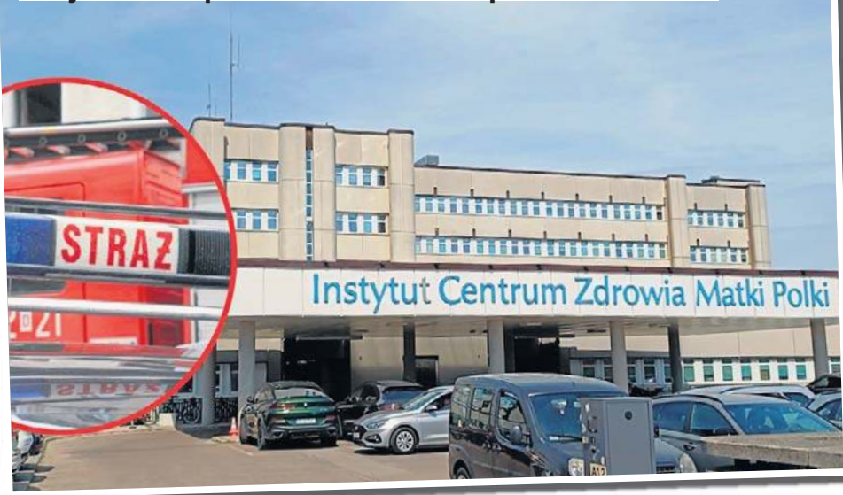
W tym roku w szpitalu doszło też do zalania pracowni rezonansu.
