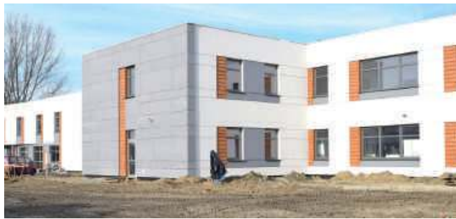
Roboty budowlane idą zgodnie z planem, wciąż potrzeba jednak pieniędzy, by w całości ukończyć inwestycję
