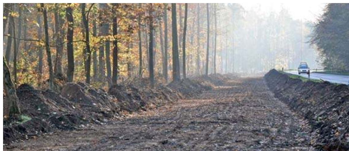
Przy budowie ścieżki rowerowej roboty ziemne zajmują najwięcej czasu. Drzewa kolidujące z inwestycją już zostały wycięte
