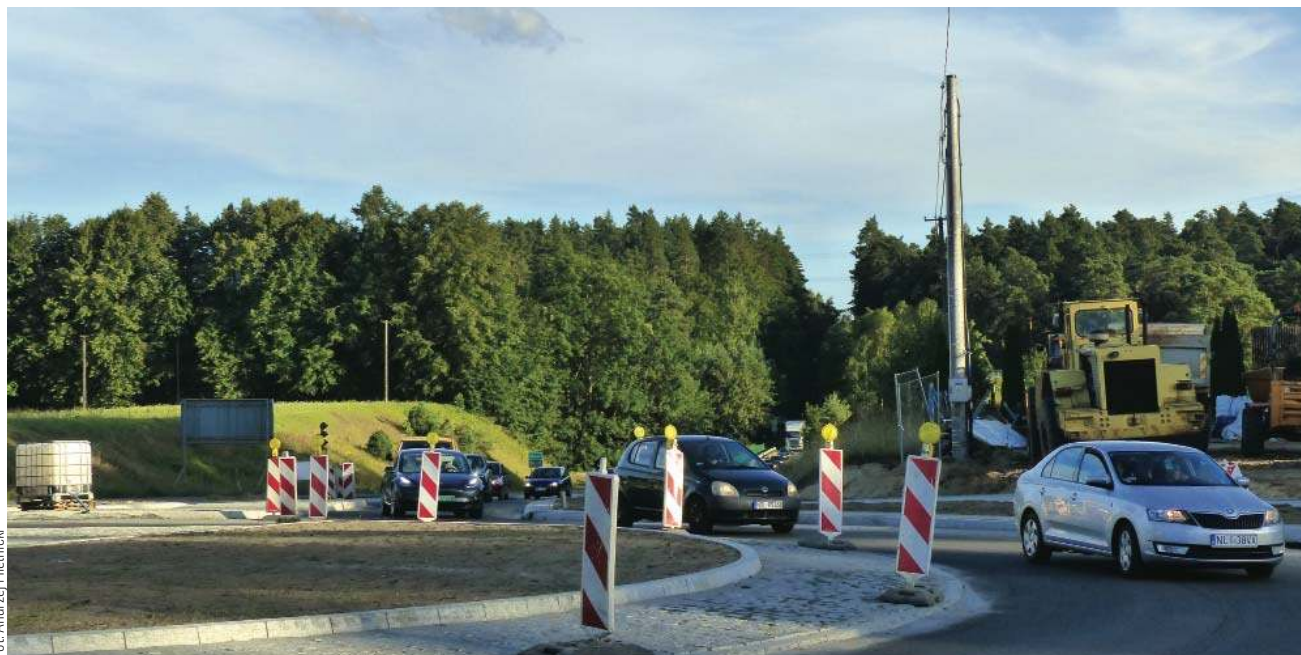
Rondo powstające rondo na drodze 51 koło os. Sterowców będzie ważnym elementem układu komunikacyjnego po wybudowaniu obwodnic Olsztyna i Dywit
