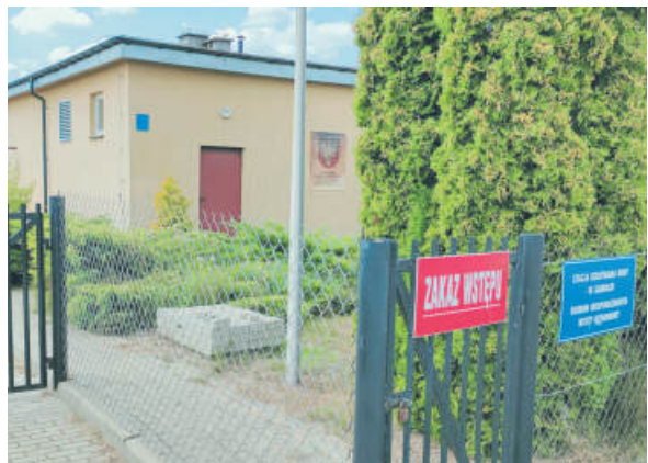
Stacja uzdatniania wody w Sabniach
