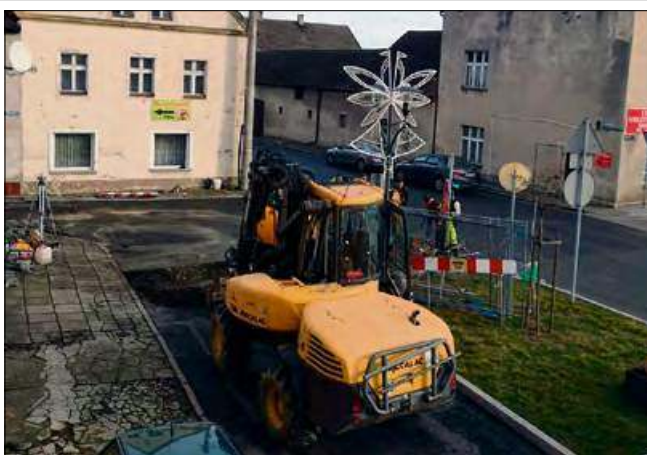
Remont potrwa do kwietnia przyszłego roku.
