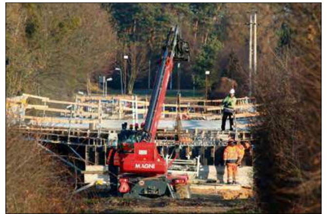
Budowa prowadzona jest równolegle z obu brzegów.
