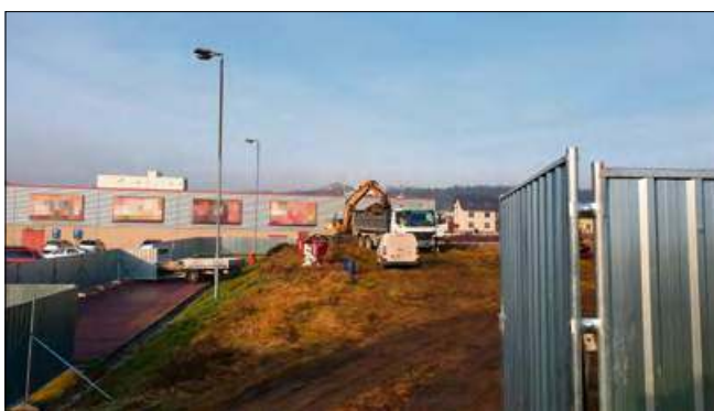
Plac budowy już gotowy.
