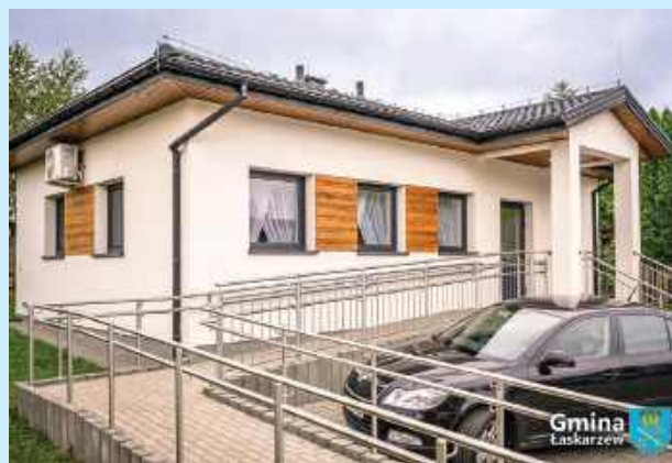
W Lewikowie wykonano prace w ramach modernizacji świetlicy wiejskiej
