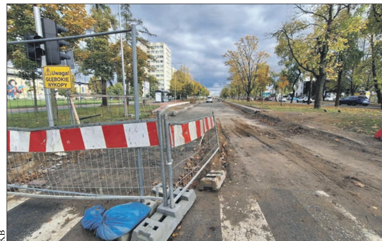
Prace w centrum trwają już od kilku miesięcy
