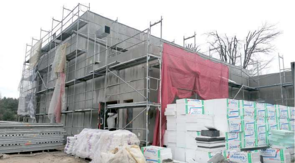
Budowa sali gimnastycznej w Dąbrowie Wronowskiej wykonana została w około 62 proc.
