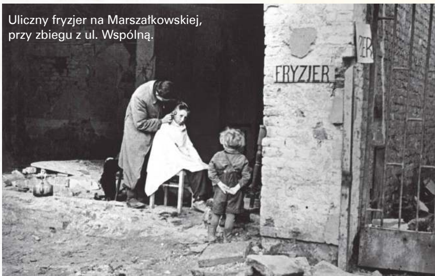
Fragment ruin Śródmieścia, prawdopodobnie strona parzysta ul. Świętokrzyskiej na wysokości ul. Mazowieckiej. Widoczna na zdjęciu kolejka z wagonikami służyła do wywożenia gruzu.
