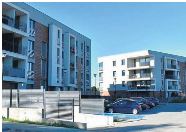
Przy ul. Sadowej rośnie nowe osiedle. Dwa z dziewięciu zaplanowanych budynków są już zamieszkane
