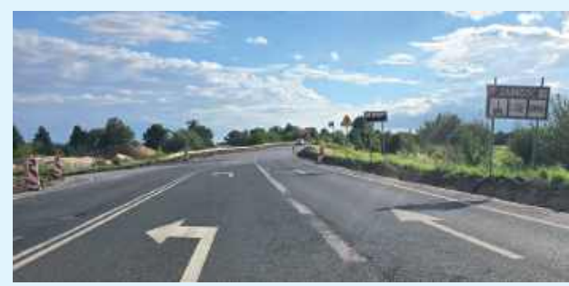
Remont drogi, która zapadła się na całej długości, potrwa trzy tygodnie
