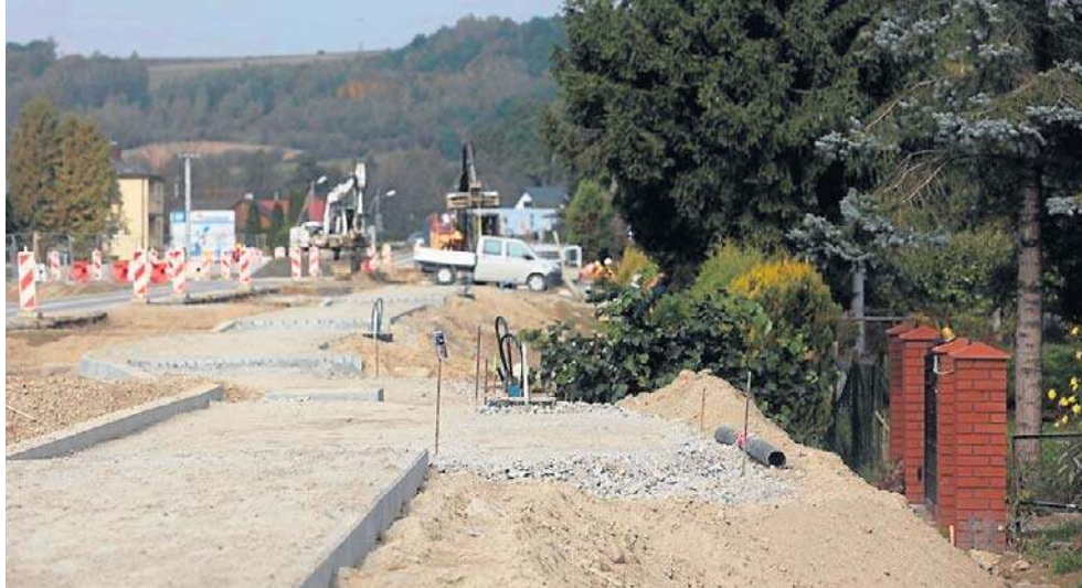
Od samego początku robót inwestycja wzbudza kontrowersje wśród lokalnej społeczności
