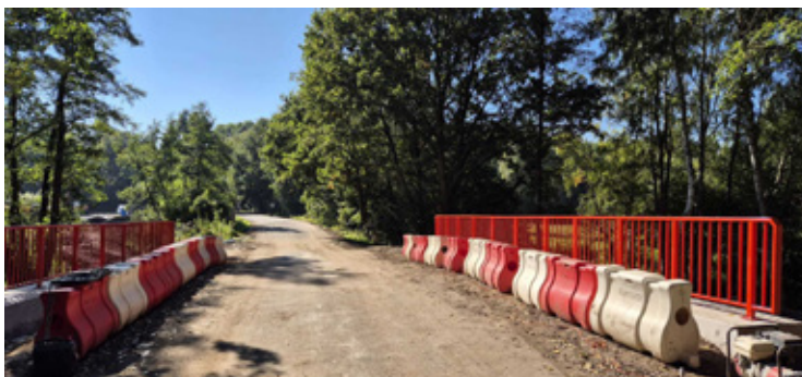
Odbudowa obiektu mostowego w ciągu drogi powiatowej 1290D, Piotroniowice – Łososiowice.
