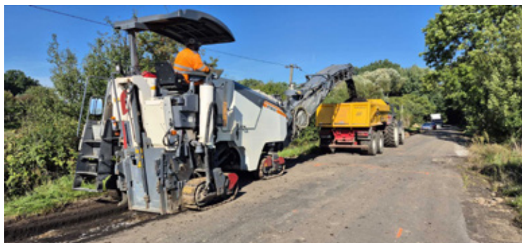
Remont drogi powiatowej nr 1290D na odcinku Piotroniowice – Łososiowice.
