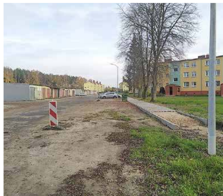
Bloki mieszkalne pozbawione są obecnie dogodnego dojazdu nawet dla służb odpowiedzialnych za bezpieczeństwo
