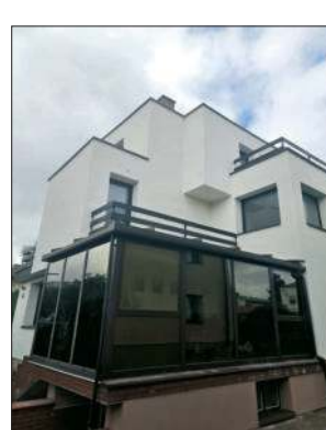
WYKONUJEMY: - DOCIEPLENIA BUDYNKÓW (STYROPIAN, WEŁNA) - DOCIEPLENIA BUDYNKÓW Z PROGRAMU „CZyste Powietrze” - MALOWANIE I MYCIE ELEWACJI - PRACE REMONTOWE WEWNĄTRZ BUDYNKU, T.J. PODWIESZANIE SUFITÓW, ZABUDOWY, GŁADZIE, MALOWANIE, PANELE, GLAZURA I TERAKOTA TEL. 603-548-801
