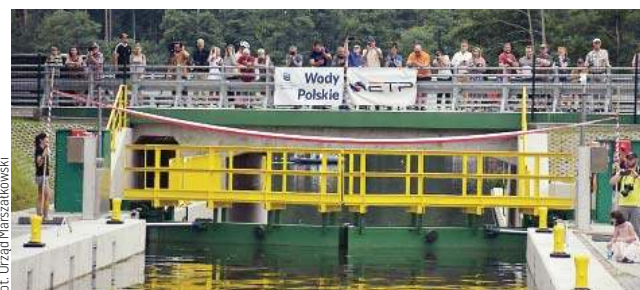
Śluza po remoncie
