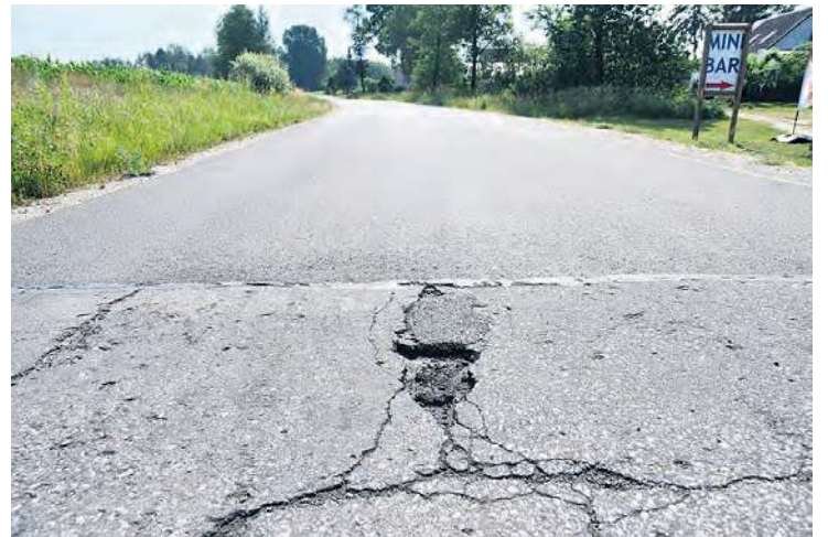
Początek/koniec 250-metrowego odcinka, który został wyremontowany. Z prawej, w tle, jest m.in. dom, w którym mieszka radny Piotr Erward. Jak mówi, mieszkańcy wsi mieli do niego pretensje, że postanowiono naprawić akurat tylko ten fragment.
