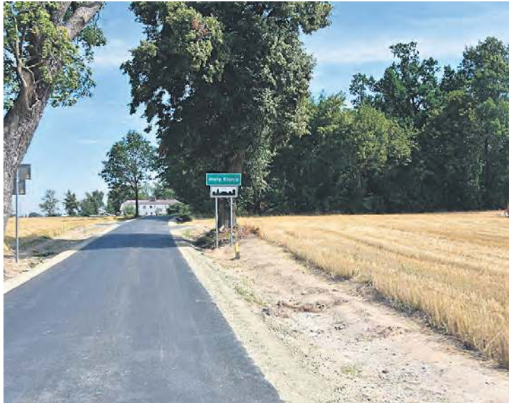
Nowa droga łącząca gminę Gostycyn z gminą Sępólno – Mała Klonia – Wilkowo.
