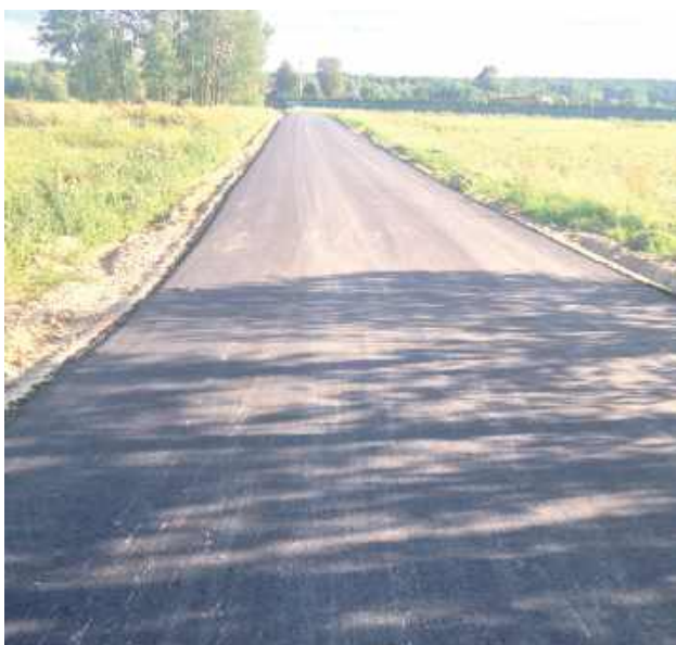
Trwają prace w Zbójnie
