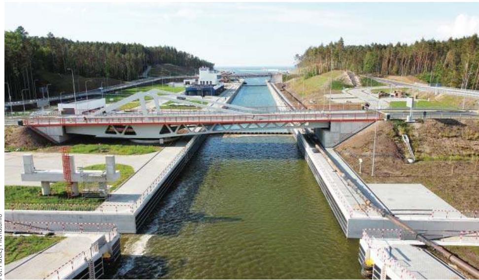
Mierzeja Wiśłana. Czerwiec 2022 na terenie budowy przekopu
