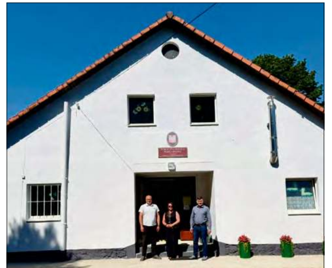
Dobiegły końca prace remontowe przy budynku przedszkola w Nakle.
