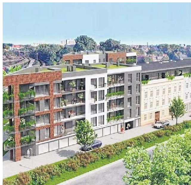
Planuje się odrestaurowanie i nadbudowę kamienic przy ul. Grunwaldzkiej i budowę budynków wielorodzinnych
