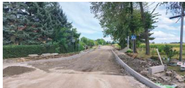
Trwają prace związane z przebudową drogi powiatowej na odcinku Gołostowice – Prusy
