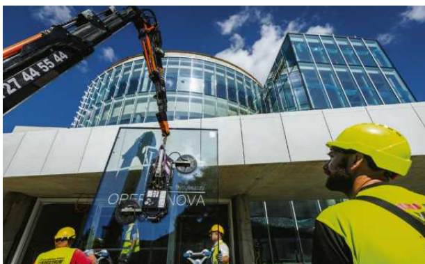
Budowa czwartego kręgu Opery Nova, fot. Tomasz Czachorowski/eventphoto.com.pl dla UMWKP
