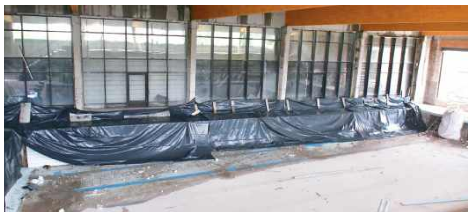
W ramach obu etapów inwestycji powstanie obiekt o łącznej powierzchni użytkowej około 3 760 m 2
