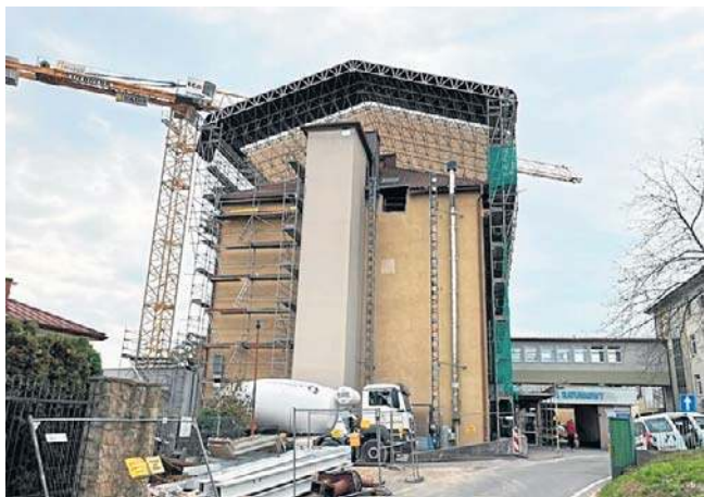
Prace przy rozbudowie budynku C szpitala w Bochni trwają już od kilku miesięcy
