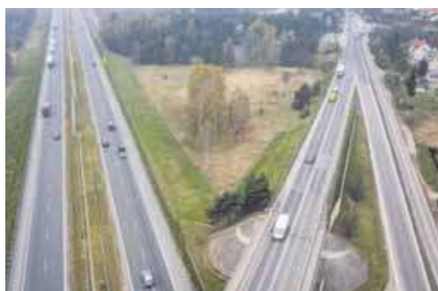
Węzeł w Byczynie Fot. GDDKiA
