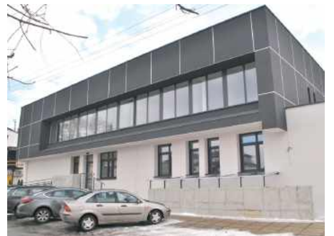
Tak prezentuje się budynek po modernizacji
