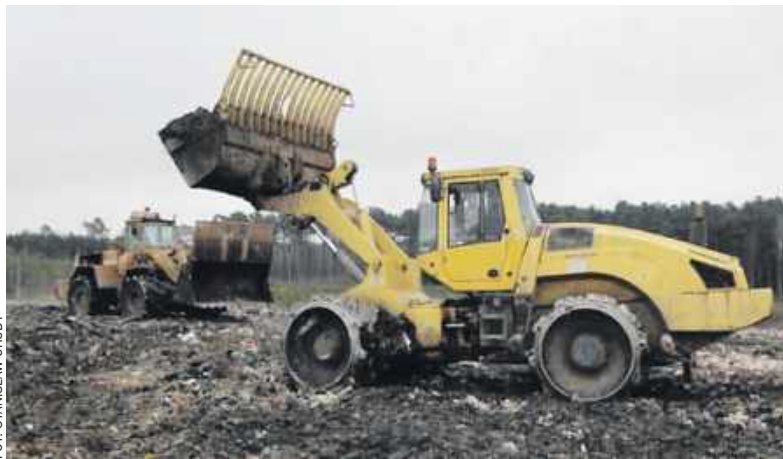
Na szczyt trzeciej niecki stalowowolskiego składowiska trafiają obecnie tylko niewielkie ilości odpadów
