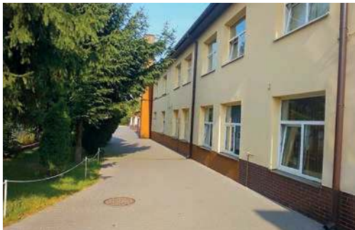
Płońska czwórka zostanie dostosowana do potrzeb osób z niepełnosprawnościami
