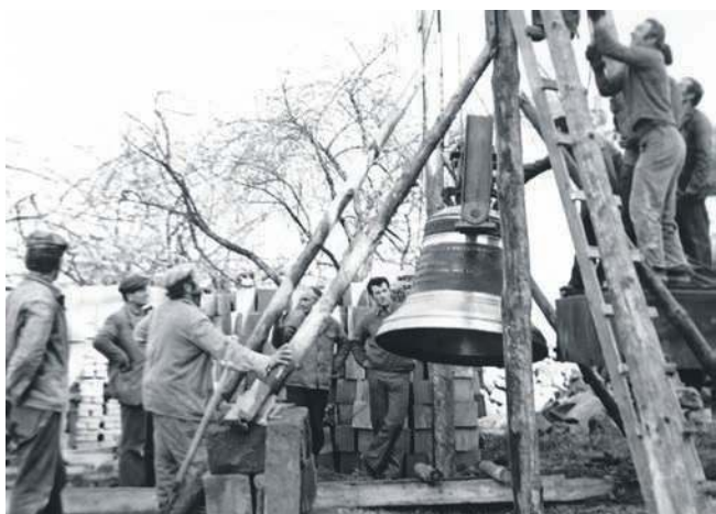
Zdjęcie z budowy kościoła w Woli Filipowskiej (koniec lat 70. lub początek 80.)
