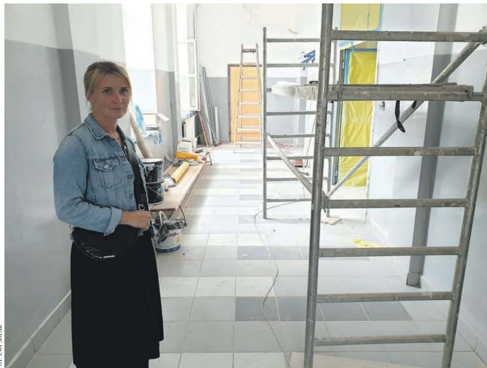
Aneta Solarz, dyrektor Gminnego Ośrodka Pomocy Społecznej w modernizowanych pomieszczeniach budynku przy ul. Krakowskiej
