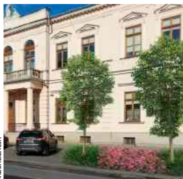
Krakowskie Przedmieście od ul. 3 Maja do ul. Ewangelickiej zazieleni się. Posadzone zostaną 13 dużych drzew, ponad 700 krzewów ozdobnych oraz rabaty o łącznej powierzchni 200 metrów kwadratowych
