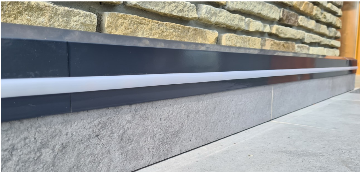
Fot. 6 Profil cokołowy na styku z elewacją
