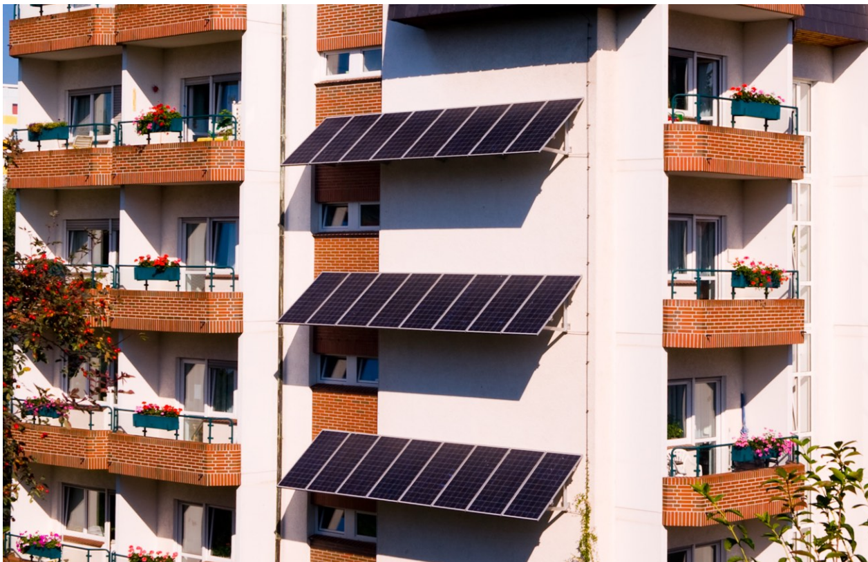
Przykład paneli PV zamontowanych pod kątem
