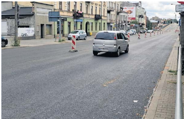
Zakończyły się prace na odcinku ulicy Słowackiego w Radomiu.
