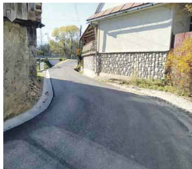
Ulica Budzowa po generalnym remoncie.
