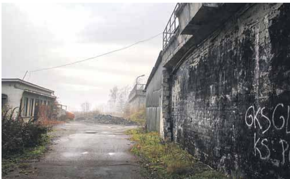
Zdegradowany teren starej oczyszczalni ścieków.
