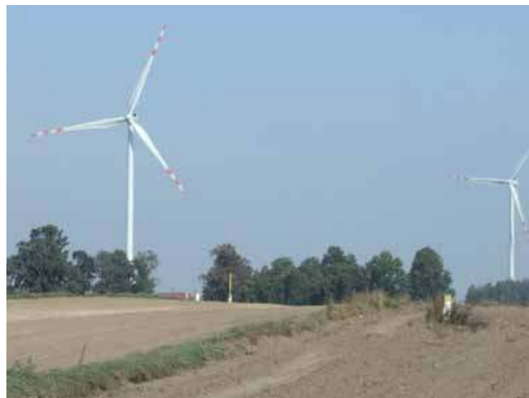
Elektrownie wiatrowe w gminie Stupsk
