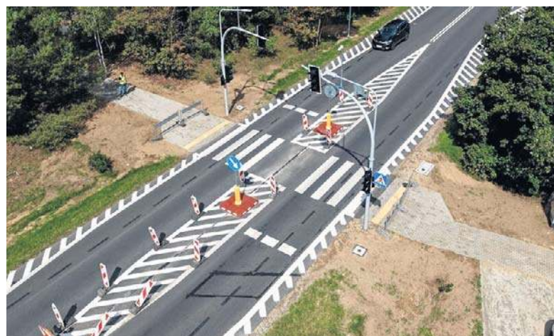
Przejście przy przystanku Toruń Katarzynka, przez ulicę Grudziądzką, zostało udostępnione pieszym
